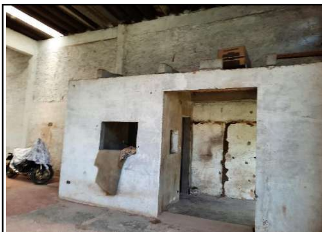
25 VISTA INTERIOR DO GALPÃO 2.
